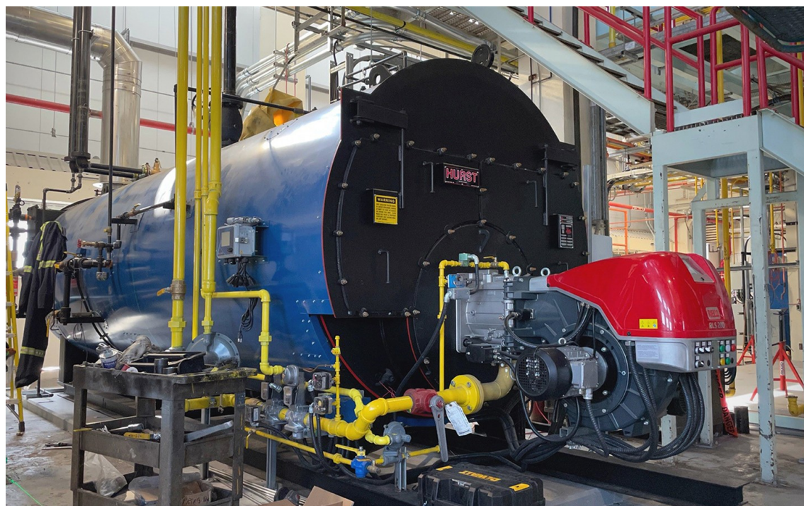
Parmis les travaux majeurs réalisé au cours du projet d'économie d'énergie de la BFC Bagotville, notons le remplacement de trois des quatre chaudières de la centrale thermique par des modèles moins énergivores.
